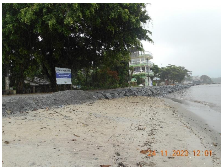
Foto 1: Início do trecho em recuperação. Defronte à Travessa Vila Espanhola.
