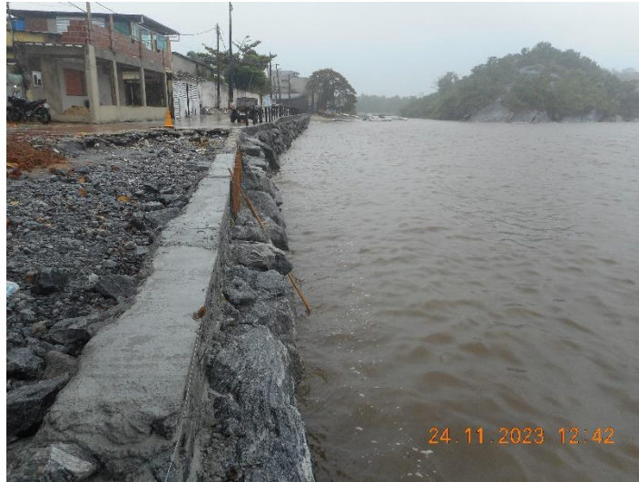
Foto 10: Idem, com detalhe do muro de contenção da benfeitoria.
