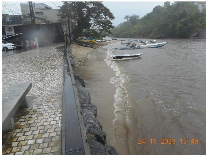
Foto 13: Trecho final do calçadão reconstruído. Próximo à Rua São Sebastião.
