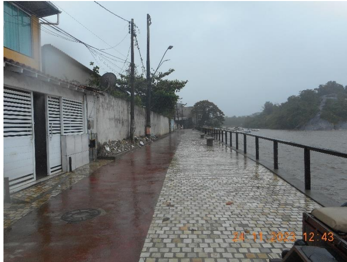
Foto 12: Trecho reconstruído do calçadão. Vista para norte.
