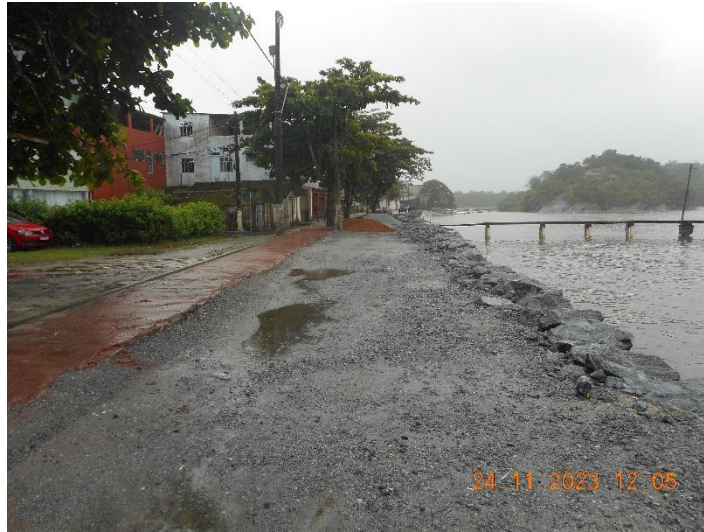
Foto 4: Muro de contenção completo. Faltando acabamento (pavimentação).
